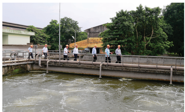
Đồng chí Nguyễn Gia Tường, TGD Tập đoàn và đoàn công tác đến thăm hệ thống xử lý nước thải của Công ty
